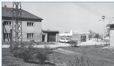
Gregorův dům před demolicí – podzim 1981
